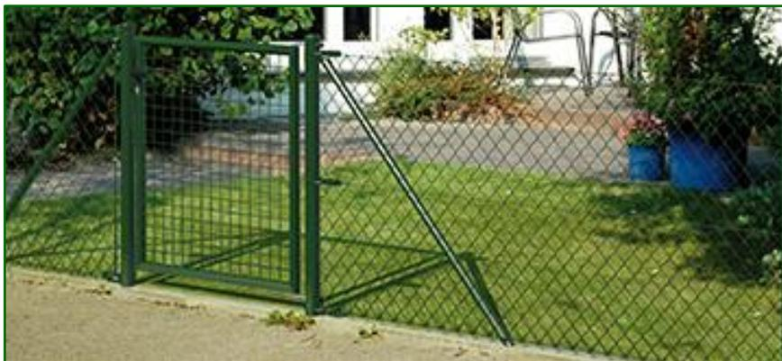
Torpfosten sollten unbedingt abgestrebt werden, hierzu benötigen Sie eine Streben + 1 zusätzliche Schelle Ø entsprechend des Torpfosten
