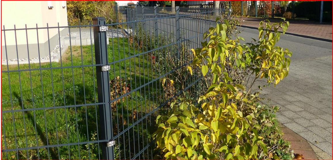
**Abbildung 1 - Doppelstabmattenzaun mit Pfostentyp WS-VA**
