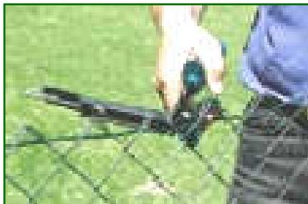
Am einfachsten befestigen Sie das Maschendrahtgeflecht an den Spanndrähten mit einer Drahtbefestigungszange.
